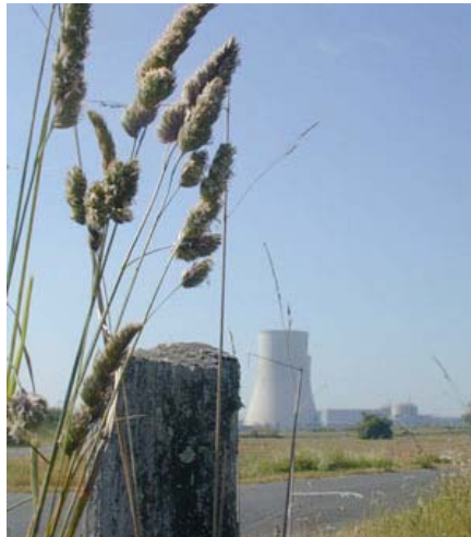
Centrale nucléaire de Civaux
