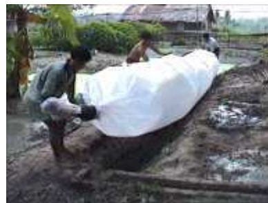
Photo 40. On place le digesteur dans la tranchée
