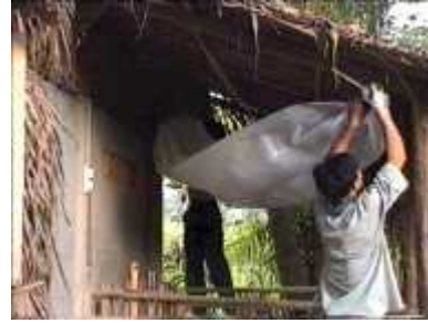
Photo 58. On suspend le réservoir en dessous du toit
