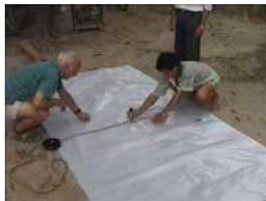
Photo 13. On fait une marque pour découper le plastique
