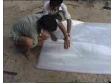
Photo 19. On commence à recouvrir le tube à l'aide du plastique
