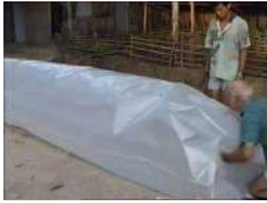
Photo 29. Le digesteur est rempli d'air
