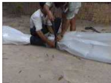
Photo 33. On fixe ce tube de plastique au tube de sortie
