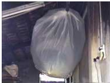
Photo 59. Un réservoir biogaz rempli !!
