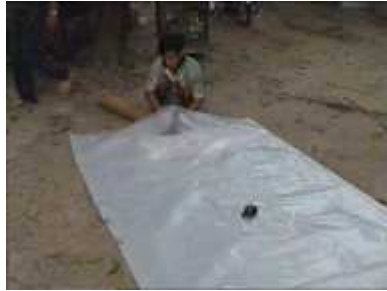
Photo 18. Mise en place du tube à l'entrée
