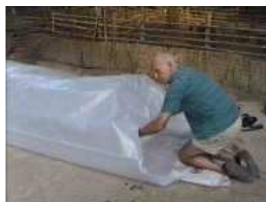
Photo 28. On pompe l'air pour remplir le digesteur
