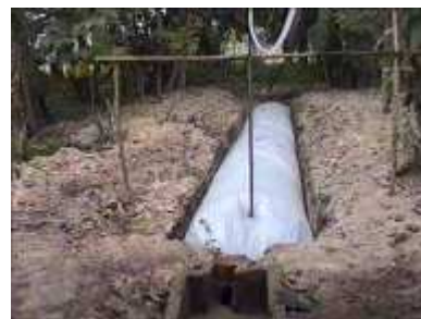
Photo 67. L'installation est terminée
