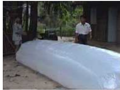
Photo 38. Le digesteur est maintenant rempli d'air
