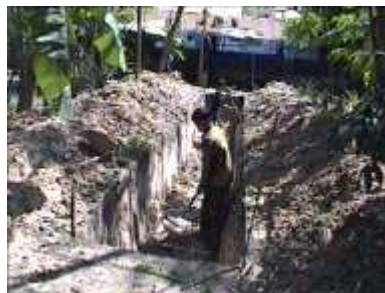
Photo 5. Réalisation d'une tranchée dans le sol
