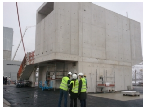
Inspecteurs de l'ASN contrôlant le 11 décembre 2012 l'avancement du chantier « appoint ultime »
