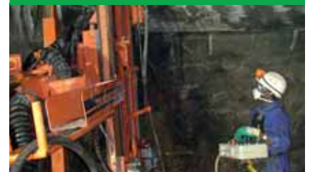
Boulonnage à la résine dans la mine de COMINAK
