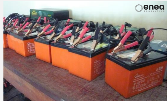
Figure 12 : Batteries utilisées pour du battery-swap en Tanzanie par EGG-Energy, social business accompagné par ENEA Consulting sous forme de mécénat de compétences
