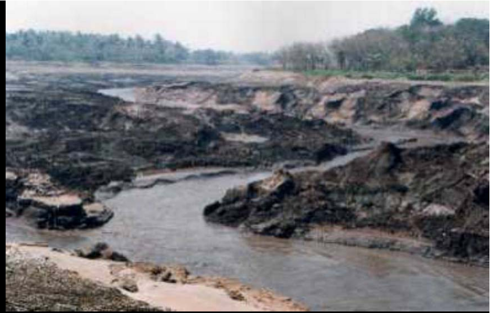
Comblement du barrage de Wingly
