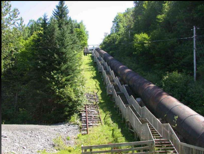
Conduite forcée amenant l'eau du réservoir à l'usine hydroélectrique
