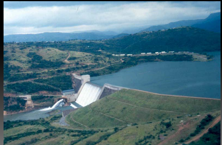
Barrage d'Inanda (Afrique du Sud)
