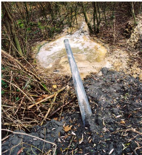
Tuyau de rejet dans un parc à boues
