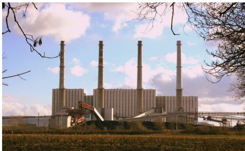
Centrale thermique de Blénod – 3 décembre 2007
