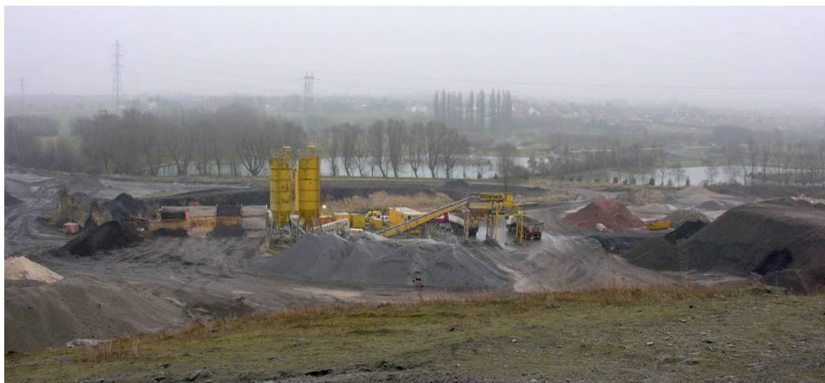
Vue des installations de mélanges ternaires depuis le haut du terril, orientation sud-est
