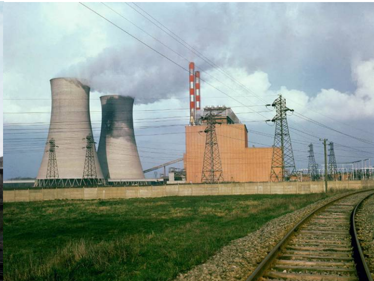
Centrale de Courrières
