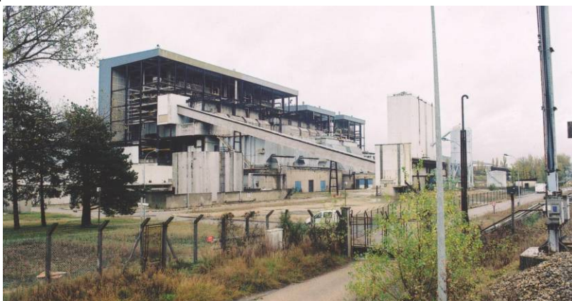
La centrale thermique de Loire sur Rhône. Novembre 2008
