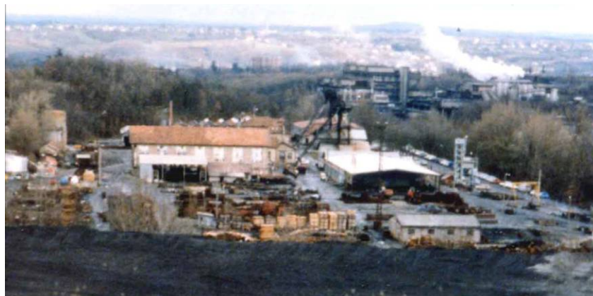
Puits de la Tronquié. Blaye-les-Mines.
