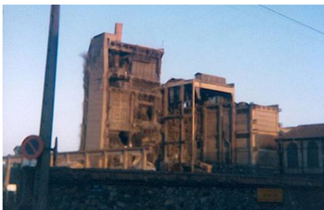
Le dynamitage de la centrale
