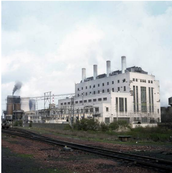
Centrale de Harnes
