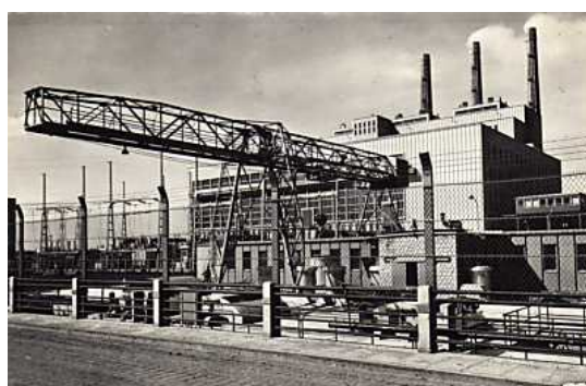
La seconde centrale
