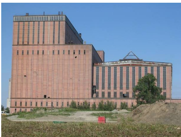
La centrale thermique de Strasbourg – 25 juillet 2008
