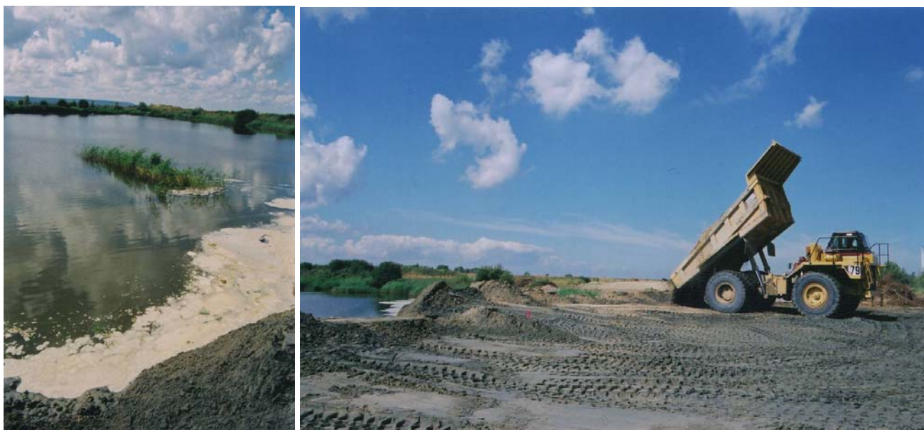
Utilisation de cendres en remblaiement pour Port 2000
