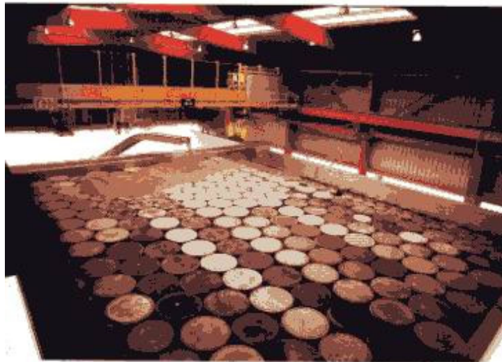
Gravillonnage des colis de déchets 'A' au Centre de Sauternes
