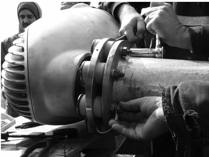
III. 5 Mettre la turbine à la terre sur le mât
