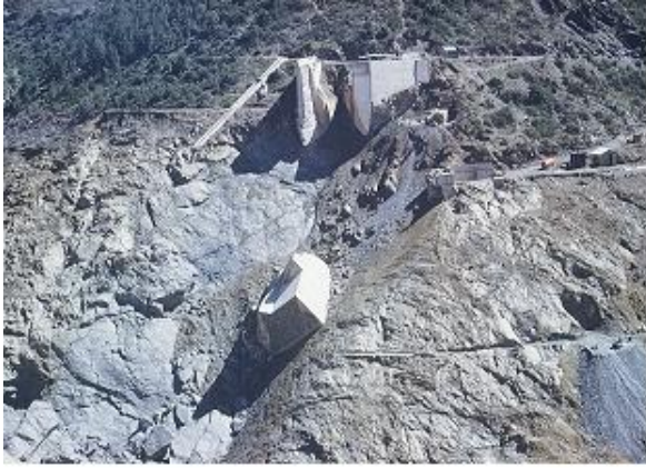
Figure 3 : Deux images clés après la rupture : à gauche, rive gauche, le dièdre excavé par le flot, avec une demi culée éboulée après ce flot, sa face aval est un plan de faille, sa face amont un ensemble de déchirures suivant la foliation ; à droite, rive droite, la crevasse ouverte sur toute la hauteur entre le béton et le rocher (photos P. Duffaut, printemps 1960).
