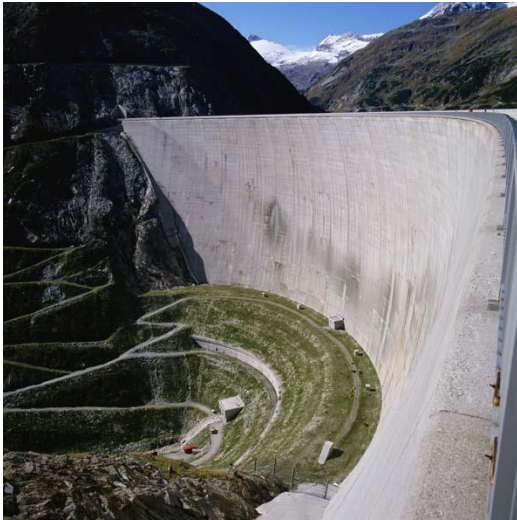
Figure 11 : le barrage de Kölnbrein, au pied duquel la végétation cache le massif de renfort (66 000 m 3 de béton) clavé contre la voûte par des vérins (photo Malta Kraftwerk)
