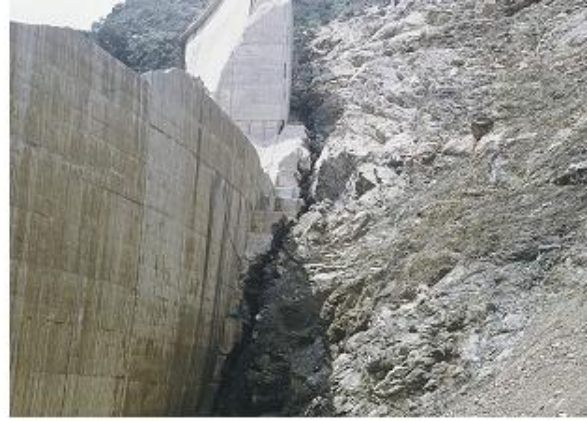
Figure 3 : Deux images clés après la rupture : à gauche, rive gauche, le dièdre excavé par le flot, avec une demi culée éboulée après ce flot, sa face aval est un plan de faille, sa face amont un ensemble de déchirures suivant la foliation ; à droite, rive droite, la crevasse ouverte sur toute la hauteur entre le béton et le rocher (photos P. Duffaut, printemps 1960).
