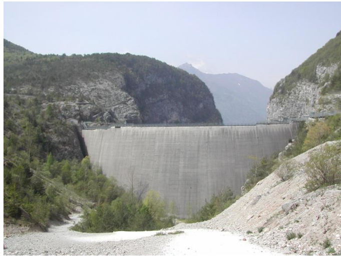
Figure 12 : le barrage de Vajont vu d'amont : le terrain glissé ne laisse voir que la partie supérieure, la route de crête a été emportée ; la trace de la vague en rive gauche est visible à l'absence de végétation sur 100 m plus haut (photo de l'auteur, mai 2003)
