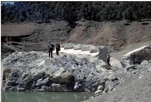
Figure 4 : les deux principaux blocs de béton, à l'amont du second coude de la vallée, larges de 13 m (épais de 6 à 7 m et hauts de 8 à 10 m, ces bases des deux plots du bas de la rive gauche pèsent donc chacune plus d'un millier de tonnes) ; au premier plan, le rocher est identifié par sa couleur sombre alors que le béton est clair (photo J. Duffaut 20 décembre 1959).
