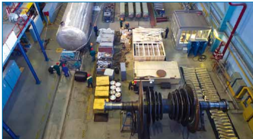
На роторе ЦНД-4 ведется замена лопаток 5-ой ступени
