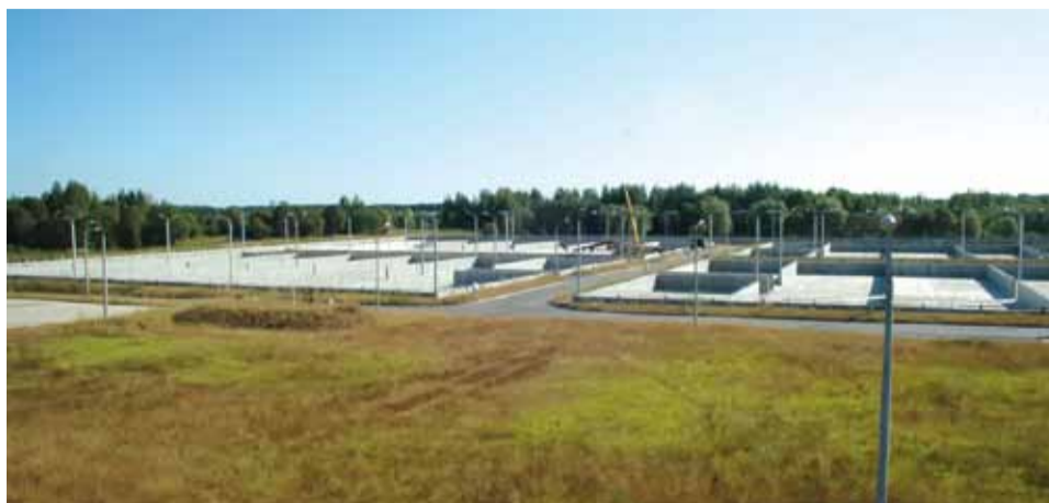
Внешний вид карт складирования промышленных отходов
