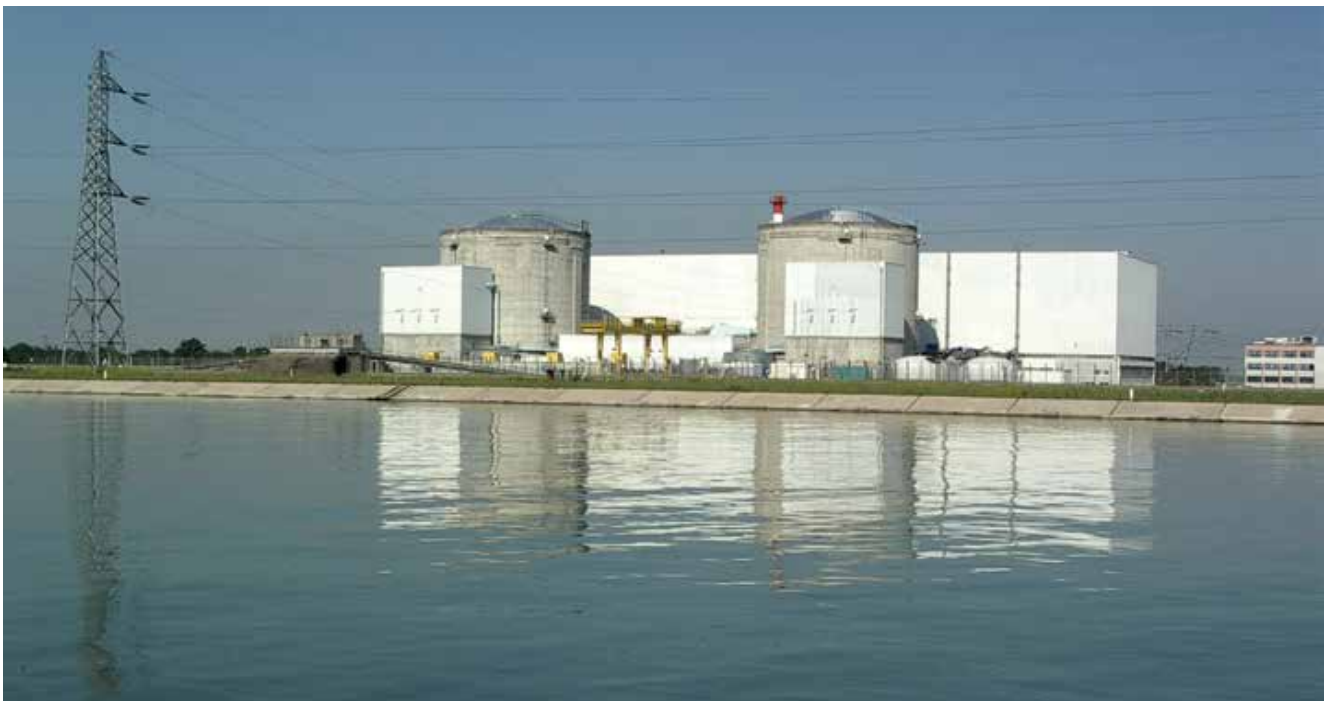
Centrale de Fessenheim
