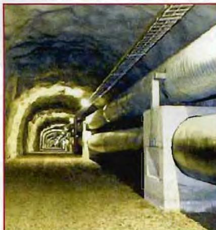
Fig. 3 - Vue d'artiste d'un tunnel de chauffage urbain à Helsinki
